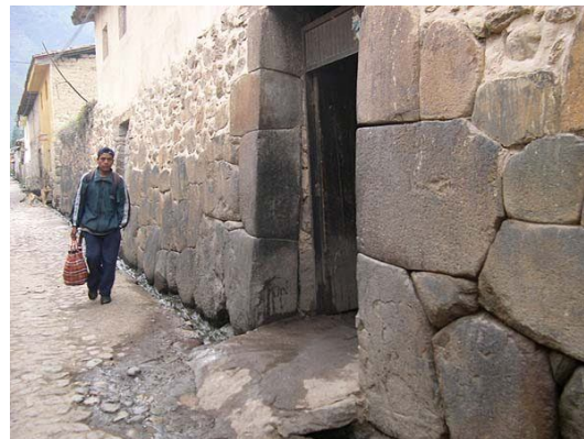
Рисунок 22: Стены с полигональной кладкой на улицах Ольянтайтамбо (Перу).
